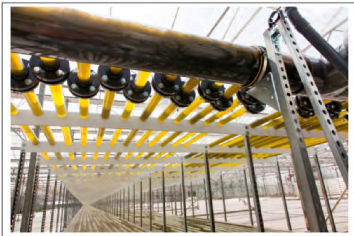
شکل ۵: ۶/۵ کیلومتر لوله PVC-U شفاف سایز ۵، ۶۳× میلی‌متر که در یک تکنولوژی موج شکنی PBR لوله‌ای با ۲۶۰ متر طول حلقه و ۱۸۰۰۰ لیتر حجم استفاده شده است. زیست توده جلبک در صنایع غذایی استفاده می‌شود. (عکس: LGEM BV، هلند)
