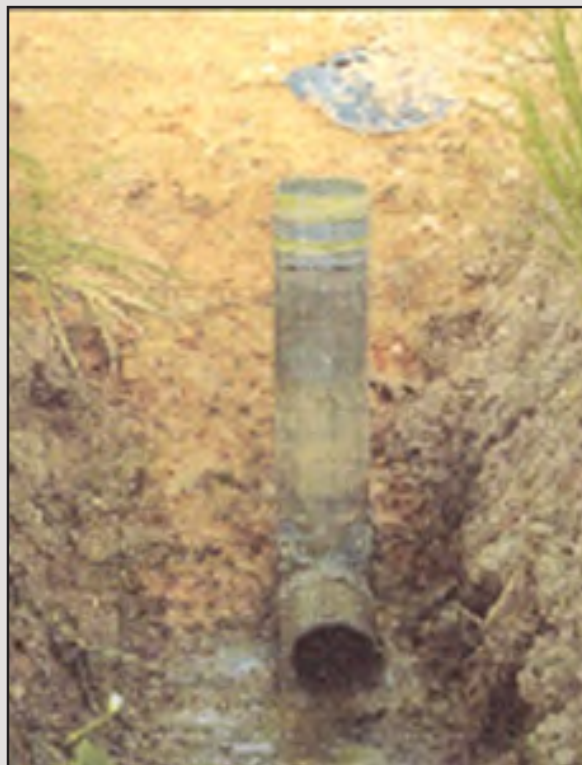
شکل ۳- دریچه آب PVC نصب شده در شالیزار برنج
