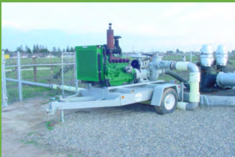
شکل ۳: نیروگاه پمپاژ قابل حمل. توجه داشته باشید که آب سنج در فاصله ۸ اینچی بیرون از حصار امنیتی دیده می شود.
